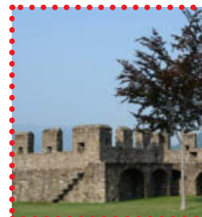
Mura della corte occidentale
