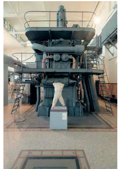
Sopra, statua nella Sala Macchine. Sotto, visione panoramica della Sala Caldaie.
