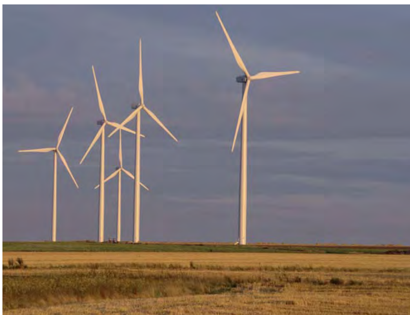
Centrale eolica a Caen in Francia.
