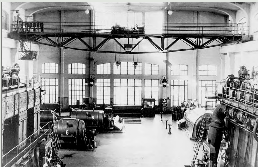
Centrale Termoelettrica Giovanni Montemartini, interno della Sala Macchine, 1950 circa. Si vedono le turbine a vapore numerate sulla cassa dell'alternatore.
