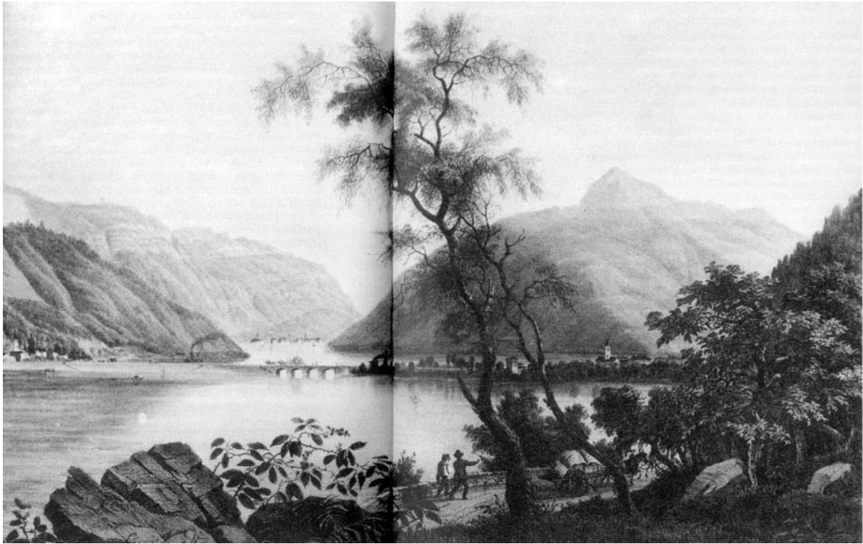
Ponte-diga fra Melide e Bissone sul lago di Lugano (1847) (L. LAVIZZARI, Escursioni nel Cantone Ticino , Locarno 1988, p. 140-141)
